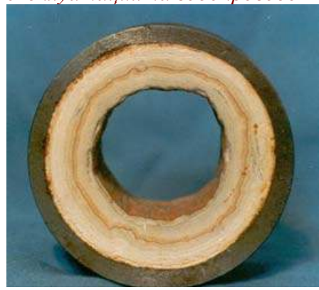
Рис.2.5.3.р.1 Срез стальной трубы после 8 лет эксплуатации на водопроводе
